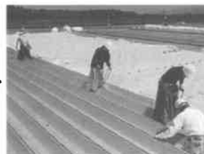
上葺折板施工
