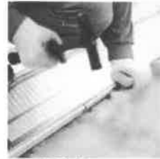
③上葺折板施工
