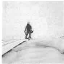
②グラスウール敷き込み
