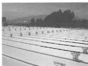
下葺折板に断熱金具取付け
