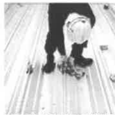
①上葺用断熱金具取り付け
