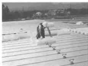
グラスウール敷き込み
